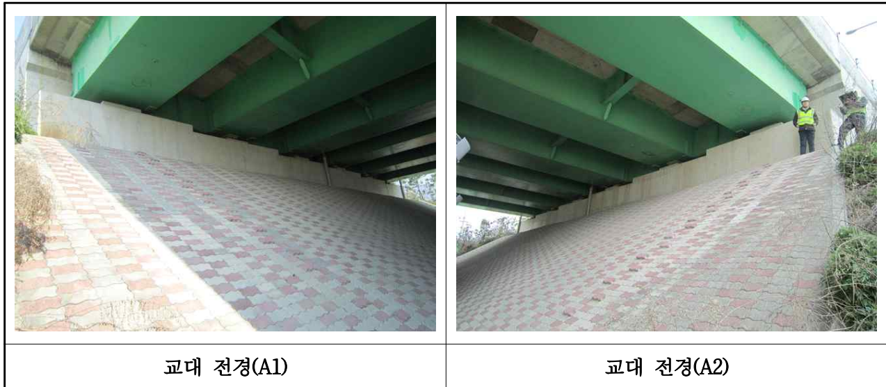
【사진 3.9】 교대 전경
