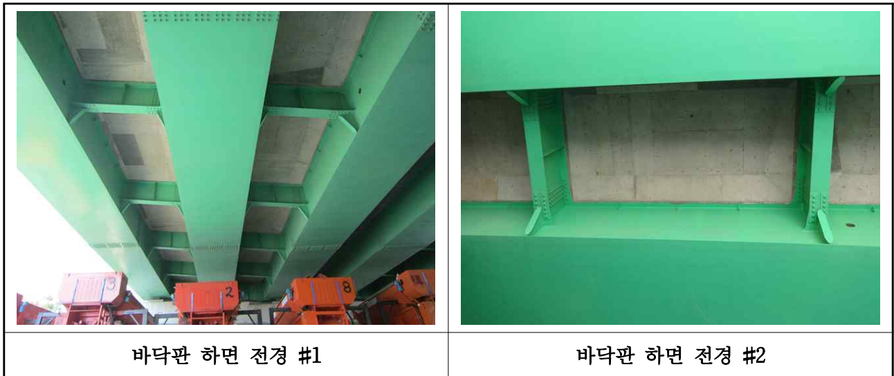
【사진 3.2】 바닥판 전경
