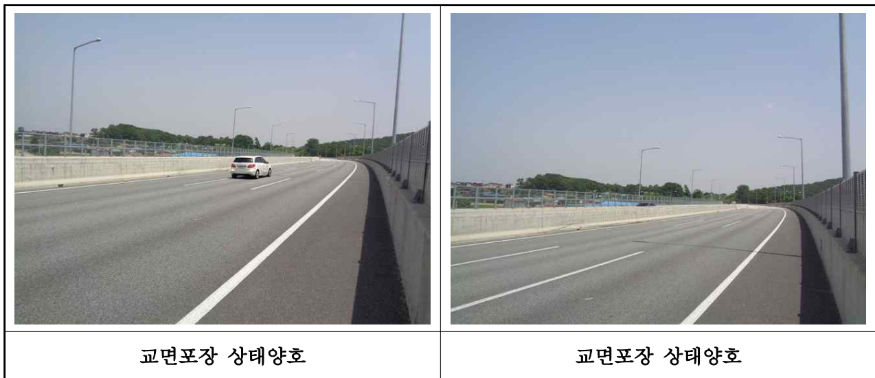
【사진 3.20】 교면포장 손상현황
