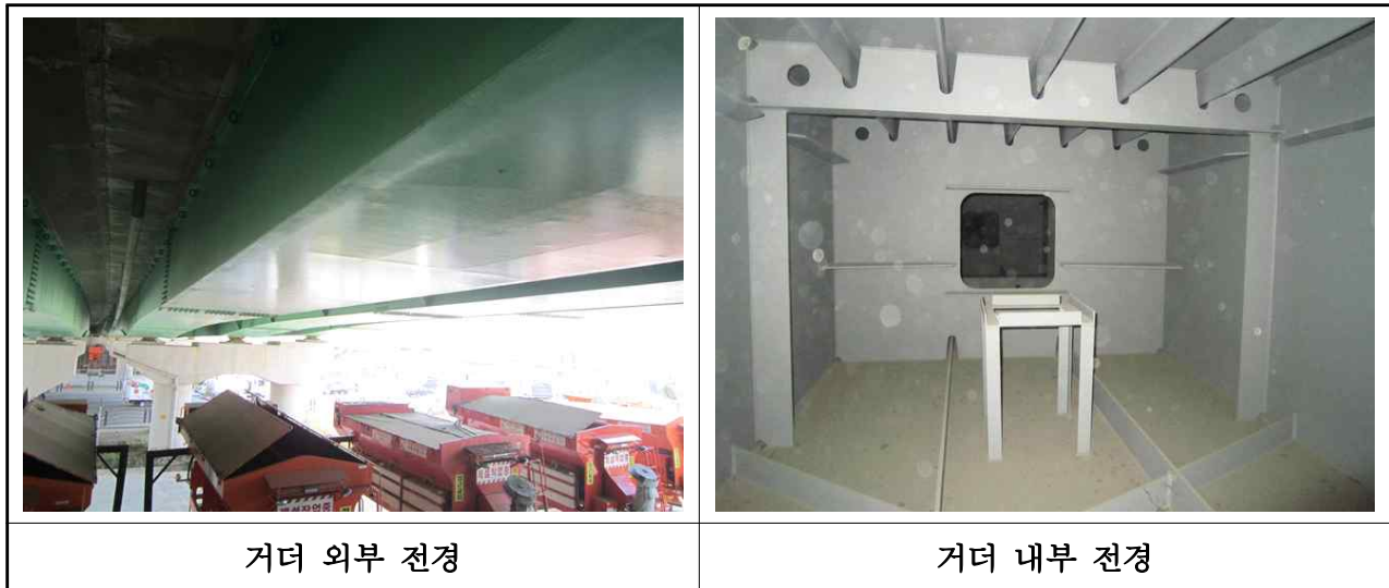
【사진 3.4】 거더 전경
