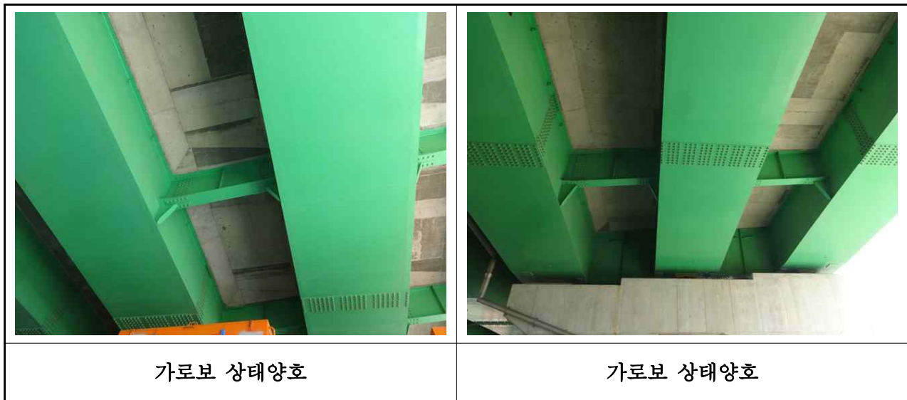
【사진 3.8】 가로보 및 세로보 손상현황
