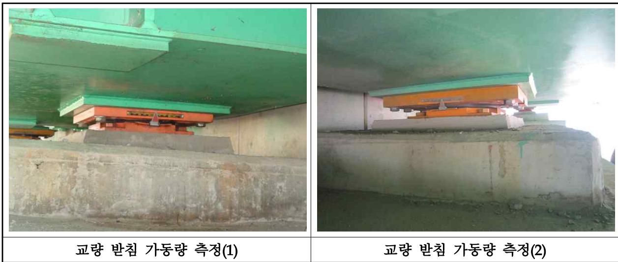
【사진 3.16】 교량받침 이동량 측정
