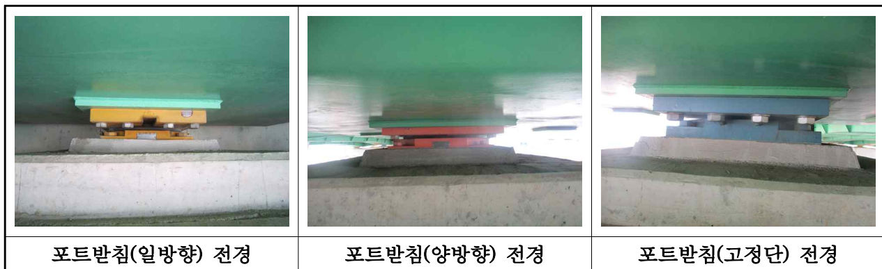
【사진 3.13】 교량받침 전경
